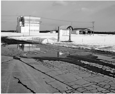
町が新年度に整備を進める町多目的航空公園。左手前の砂利道を舗装し、駐車場の周囲に垣根を設ける。左奥はJAXAの管制塔
