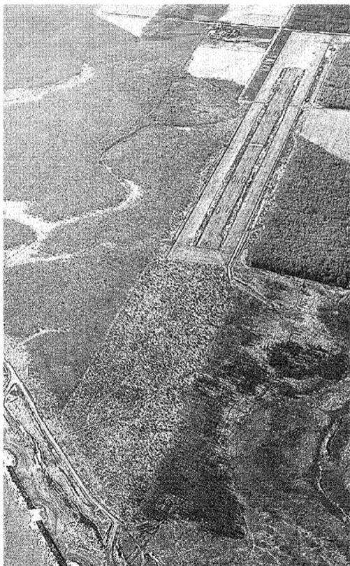
海に近く、周囲が広く開けた大樹町多目的航空公園。飛行船が飛ぶ日も近い
